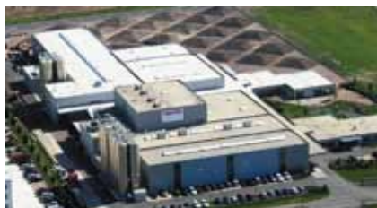
Proizvodni center za STARstrap povezovanje v Nemčiji (production centre for STARstrap strapping in Germany)
