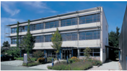
Site recherche et développement en Allemagne
