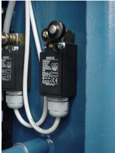
Figure 4: Est-ce que les interrupteurs de fin de course sur le chariot fonctionnent correctement?
