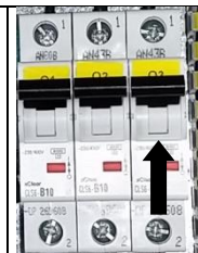
Fig.3 (Q3) Variateur du plateau tournant
